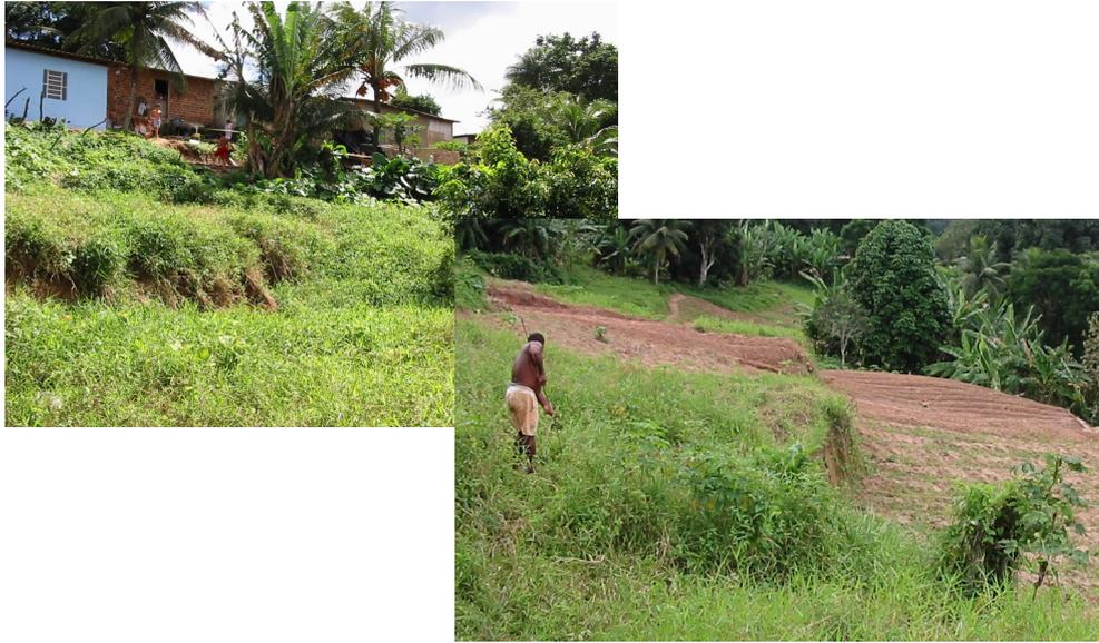
Figura 19 – deslizamento rotacional com quatro degraus de abatimento (fotos Alheiros, 2003)
