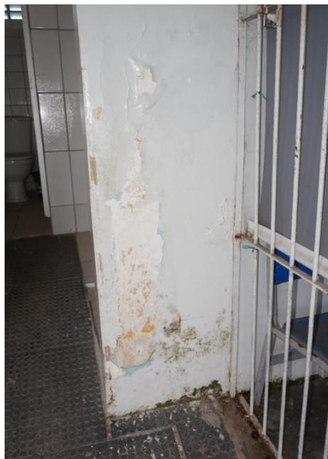
FOTO 26 – Retirada do reboco com aplicação de novo reboco - após colocar cerâmica a meia parede inferior (1,7m) e pintura em tinta látex na meia parede superior.
