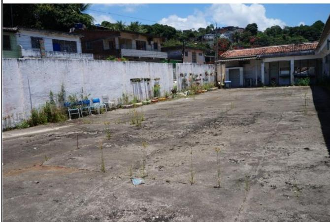
FOTO 01- Recuperação do piso cimentado. – refazer com aproveitamento do material a ser quebrado como base para novo piso.
