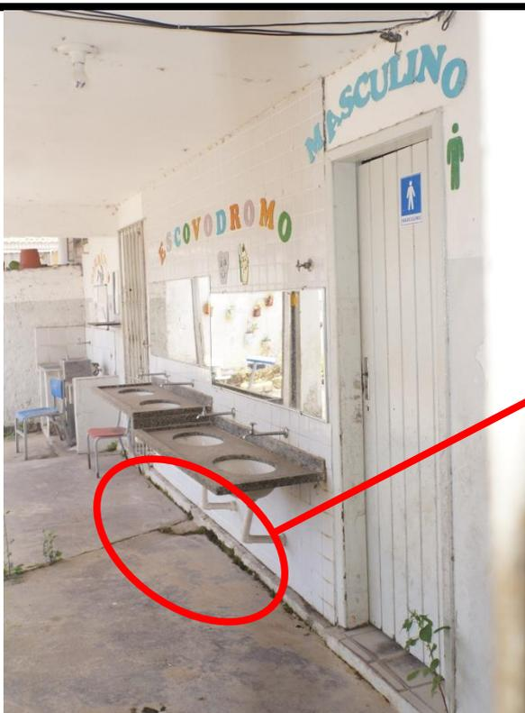
FOTO 23 - Recuperação do piso cimentado. – refazer com aproveitamento do material a ser quebrado como base para novo piso.
