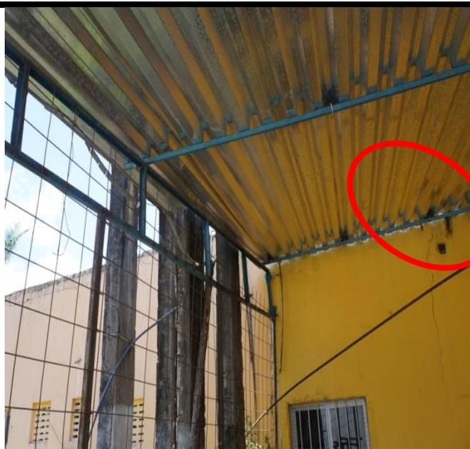
FOTO 19 – Retirada da estrutura de gradil existente e colocação de gradil com portão, inclusive ferragens.
