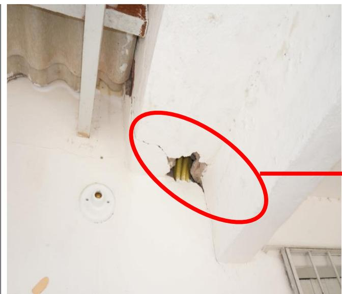
FOTO 21 – Instalação de caixa de passagem 4x4 e recuperação das rachaduras.
