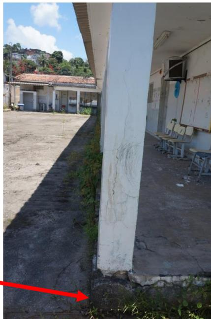
FOTO 05 – Recuperação estrutural do pilar com aplicação de graute, inclusive da base, com retirada do material desagregado, lixamento da ferragem, proteção da ferragem com primer e recomposição da ferragem quando necessário.
