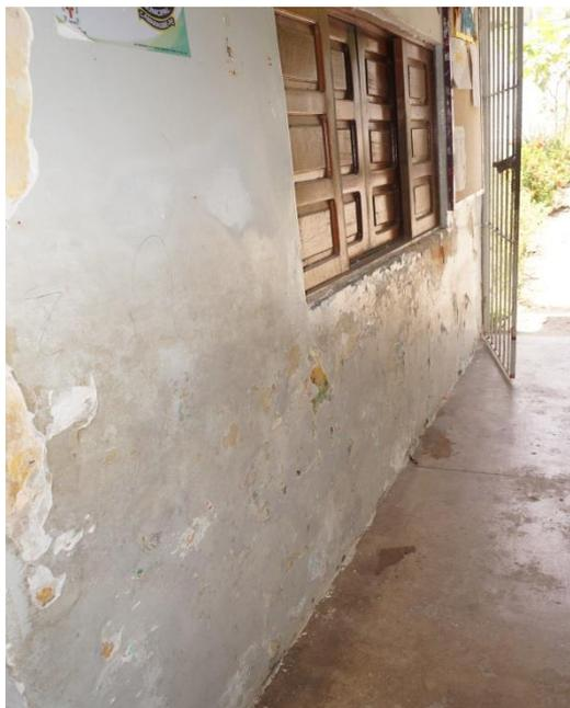
FOTO 25 – Retirada do reboco com aplicação de novo reboco - após colocar cerâmica a meia parede inferior (1,7m) e pintura em tinta látex na meia parede superior
