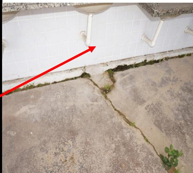
FOTO 24 - Recuperação do piso cimentado. – refazer com aproveitamento do material a ser quebrado como base para novo piso.
