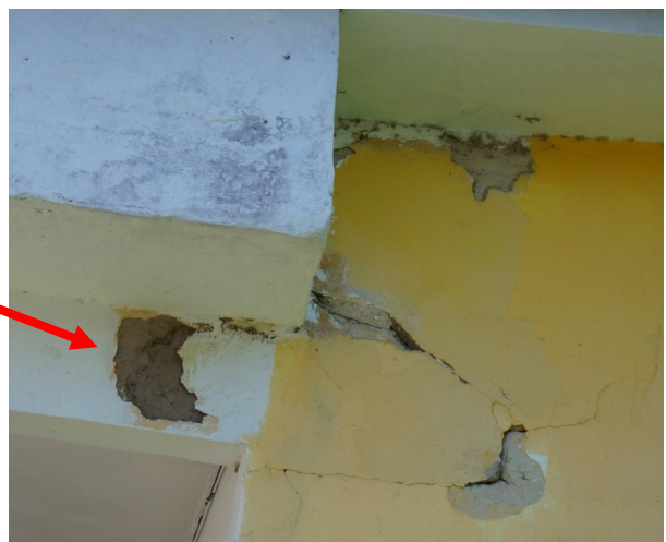
FOTO 04 - Recuperação estrutural com amarração da viga.
