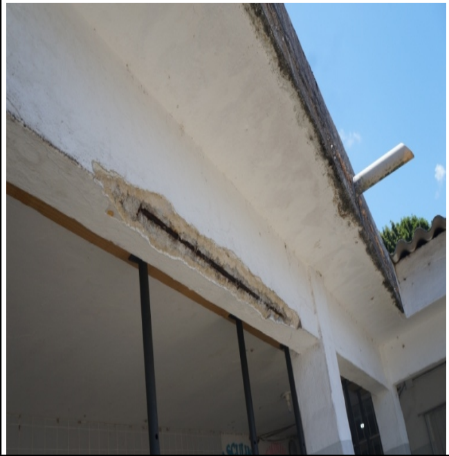
FOTO 14 - Recuperação estrutural da viga com aplicação de graute, com retirada do material desagregado, lixamento da ferragem, proteção da ferragem com primer e recomposição da ferragem quando necessário.
