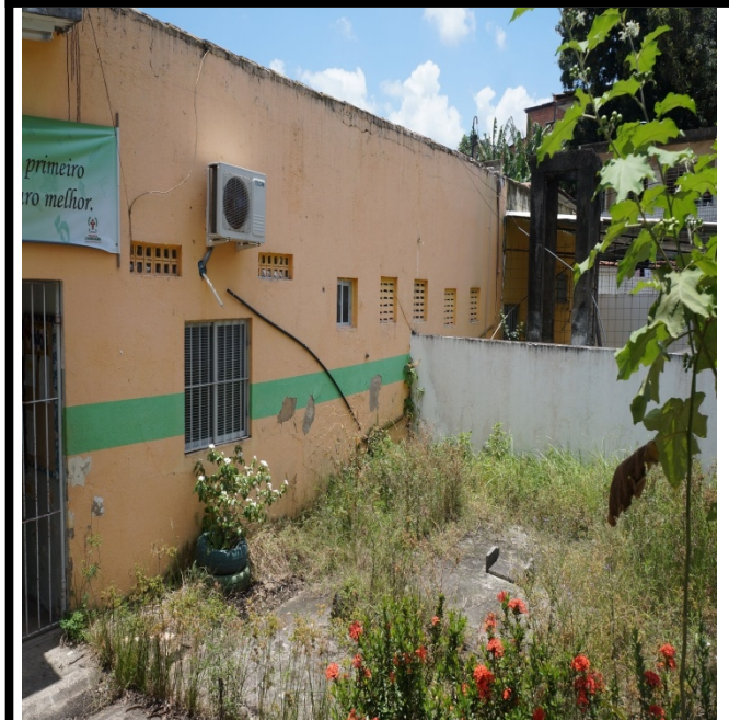
FOTO 48 – Retirada do reboco com aplicação de novo reboco - após colocar cerâmica a meia parede inferior (1,7m) na cor branco gelo e pintura em tinta látex na meia parede superior em toda a fachada frontal, lateral e de fundos.
