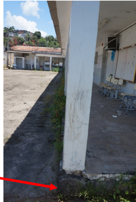
FOTO 06 – Recuperação estrutural do pilar com aplicação de graute, inclusive da base, com retirada do material desagregado, lixamento da ferragem, proteção da ferragem com primer e recomposição da ferragem quando necessário.
