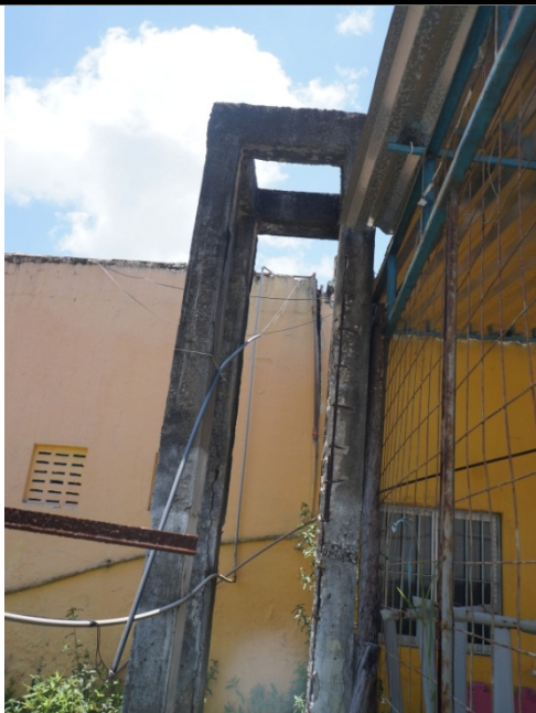
FOTO 15 - Demolição de estrutura existente para caixa d'água, devido as condições de desgaste estrutural com ferragens corroídas e estrutura em colapso.
