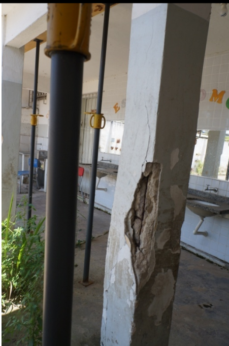
FOTO 11 - Recuperação estrutural do pilar com aplicação de graute, inclusive da base, com retirada do material desagregado, lixamento da ferragem, proteção da ferragem com primer e recomposição da ferragem quando necessário.
