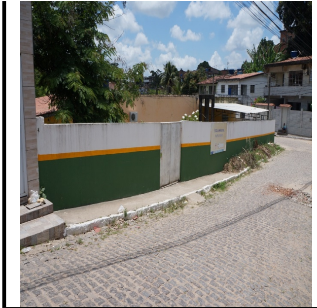
FOTO 46 – Pintura do muro lado interno e externo em tinta PVA látex.
