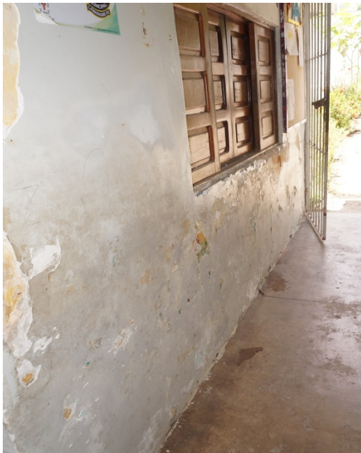
FOTO 25 – Retirada do reboco com aplicação de novo reboco - após colocar cerâmica a meia parede inferior (1,7m) e pintura em tinta látex na meia parede superior.
