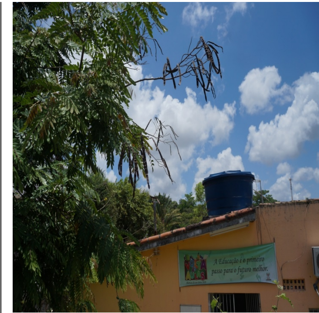
FOTO 41 – Recuperação da cobertura em telha cerâmica com reaproveitamento de 70% da telha.
