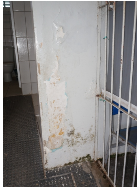
FOTO 26 – Retirada do reboco com aplicação de novo reboco - após colocar cerâmica a meia parede inferior (1,7m) e pintura em tinta látex na meia parede superior.
