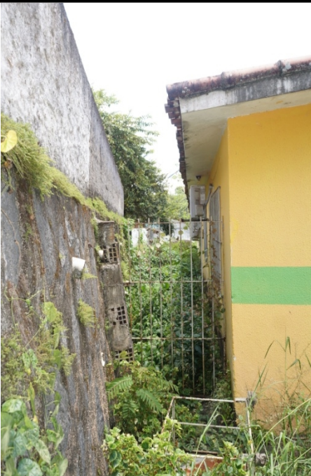
FOTO 35 – Recuperação da vala com aprofundamento da mesma e colocação de tampa removível para limpeza.
