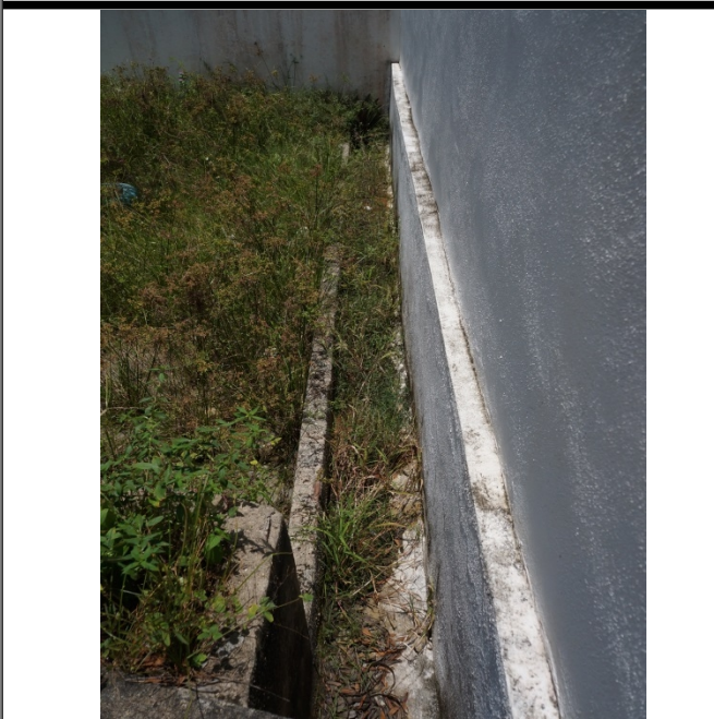
FOTO 43 – Recuperação da vala com aprofundamento da mesma e colocação de tampa removível para limpeza.
