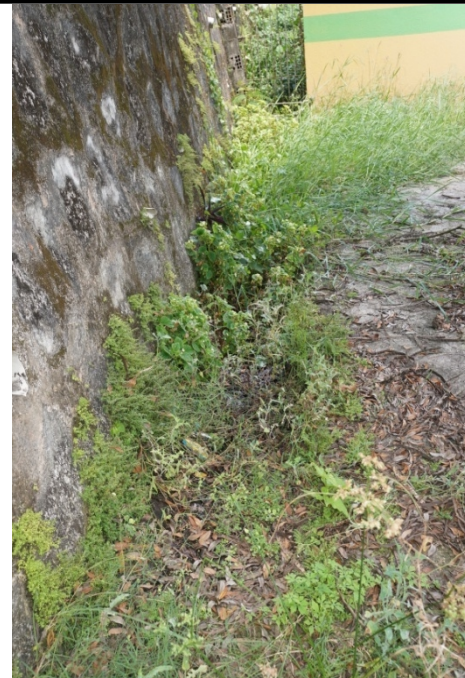
FOTO 36 – Recuperação da vala com aprofundamento da mesma e colocação de tampa removível para limpeza.
