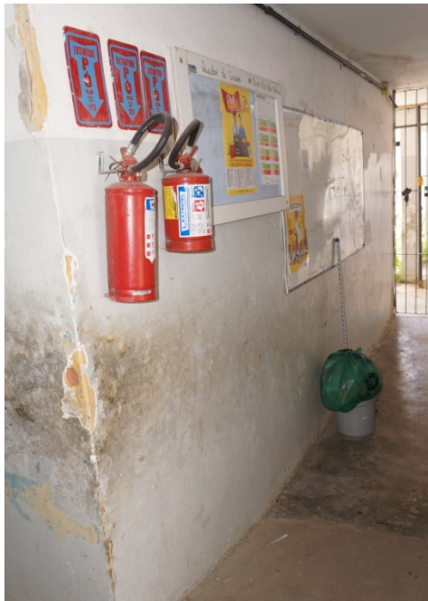
FOTO 29 – Retirada do reboco com aplicação de novo reboco - após colocar cerâmica a meia parede inferior (1,7m) e pintura em tinta látex na meia parede superior.
