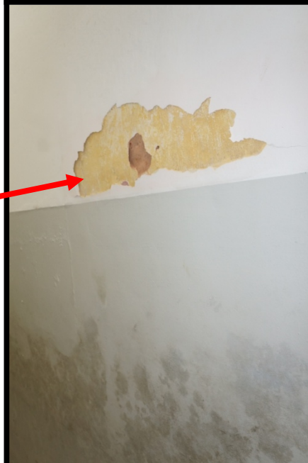
FOTO 28 – Retirada do reboco com aplicação de novo reboco - após colocar cerâmica a meia parede inferior (1,7m) e pintura em tinta látex na meia parede superior.
