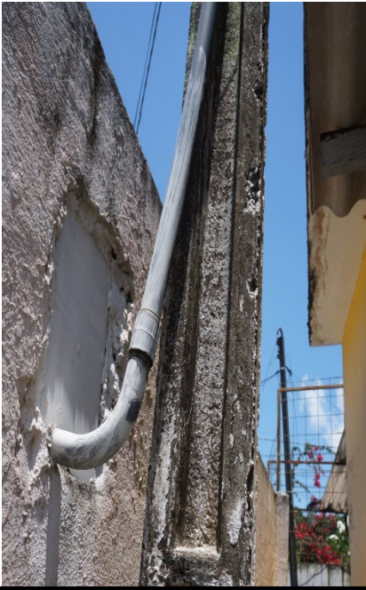
FOTO 37 – Retirada de poste em concreto DT-100/8 e instalação de novo poste em concreto DT-100/8 com instalação de medidor trifásico, disjuntor de 100A tripolar, eletroduto de 50mm e cabeamento de 25,00mm 2 .
