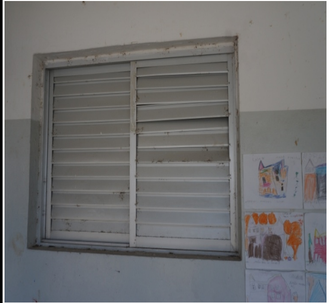
FOTO 10 – Recuperação de janela em esquadria de alumínio.
