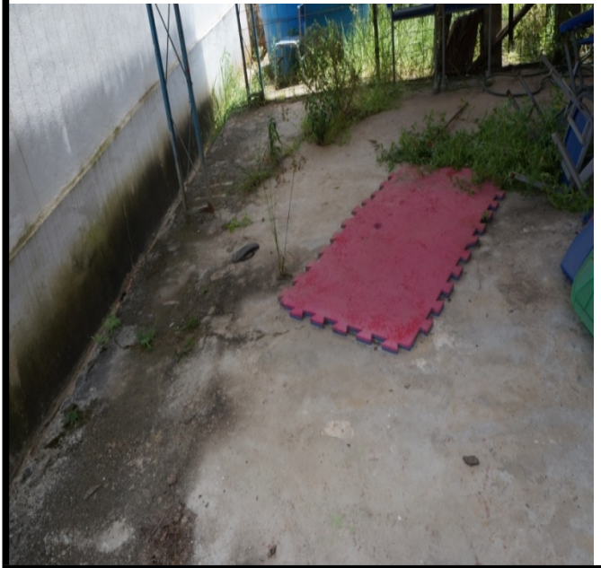
FOTO 18 - Recuperação do piso cimentado. – refazer com aproveitamento do material a ser quebrado como base para novo piso.
