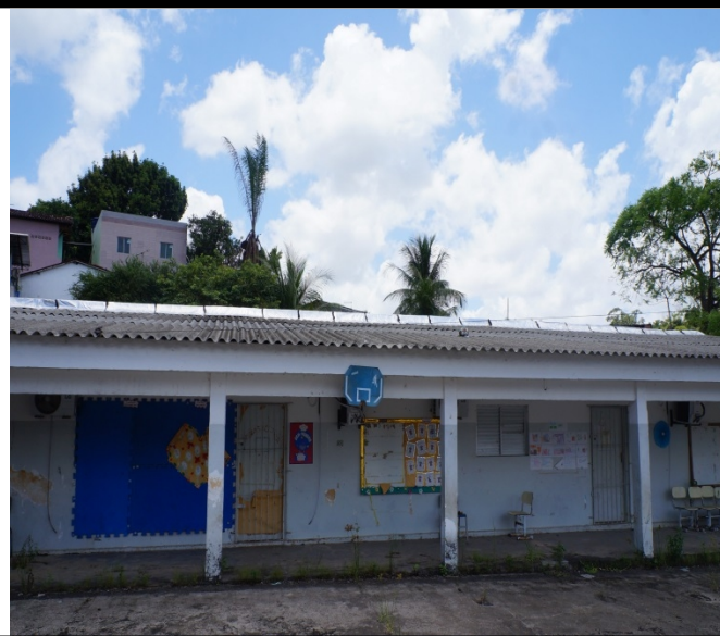
FOTO 39 – Retirada da cobertura em amianto. Execução de cobertura em cerâmica com madeiramento retomando a cobertura original da escola e reduzindo a carga sobre os pilares.
