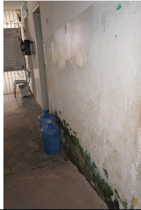
FOTO 30 – Retirada do reboco com aplicação de novo reboco - após colocar cerâmica a meia parede inferior (1,7m) e pintura em tinta látex na meia parede superior.
