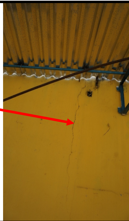
FOTO 20 – Recuperação de rachaduras com amarração com costura em Z.
