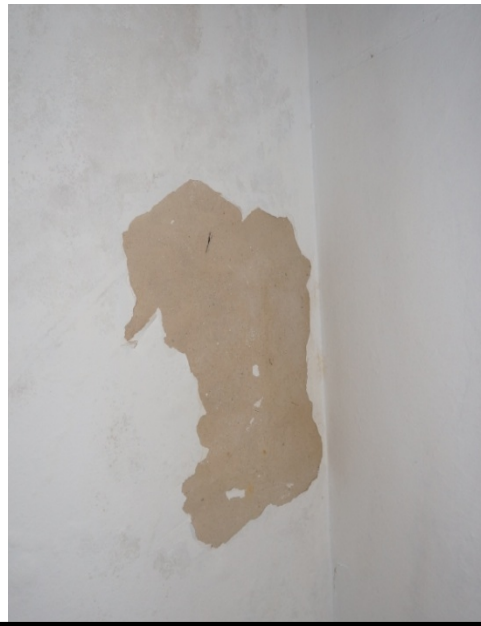
FOTO 34 – Retirada do reboco com aplicação de novo reboco - após colocar cerâmica a meia parede inferior (1,7m) e pintura em tinta látex na meia parede superior.
