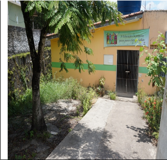
FOTO 45 – Retirada do reboco com aplicação de novo reboco - após colocar cerâmica a meia parede inferior (1,7m) na cor branco gelo e pintura em tinta látex na meia parede superior.
