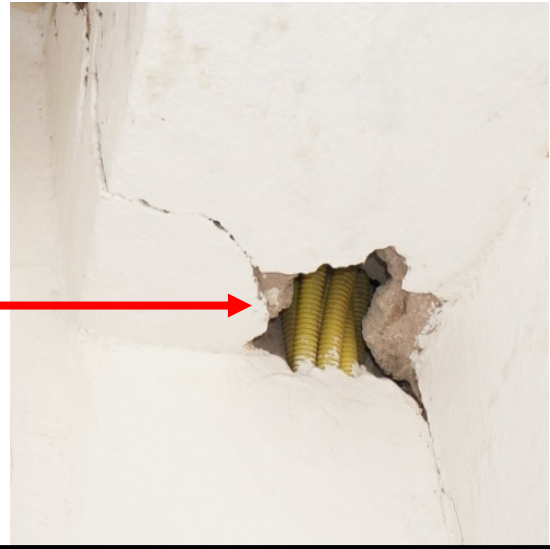
FOTO 22 - Instalação de caixa de passagem 4x4 e recuperação das rachaduras.
