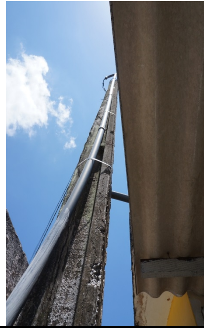
FOTO 38 – Retirada de poste em concreto DT-100/8 e instalação de novo poste em concreto DT-100/8 com instalação de medidor trifásico, disjuntor de 100A tripolar, eletroduto de 50mm e cabeamento de 25,00mm 2 .
