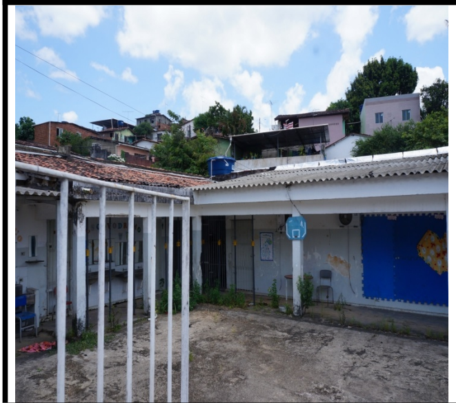
FOTO 40 – Retirada da cobertura em amianto. Execução de cobertura em cerâmica com madeiramento retomando a cobertura original da escola e reduzindo a carga sobre os pilares.
