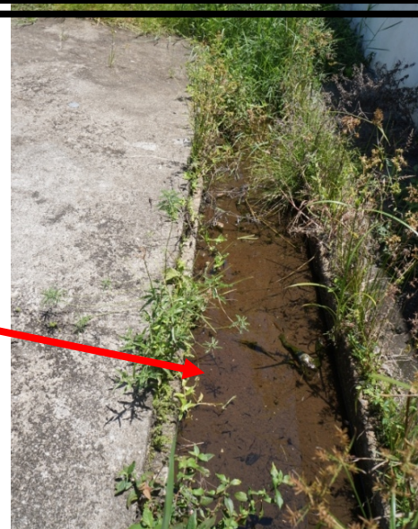
FOTO 08 – Recuperação da vala com aprofundamento da mesma e colocação de tampa removível para limpeza.
