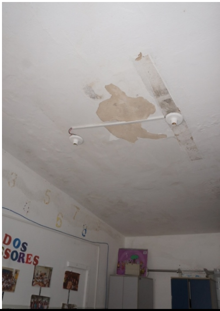
FOTO 33 – Raspagem da pintura da laje, repintura do teto com tinta látex na cor branco neve.
