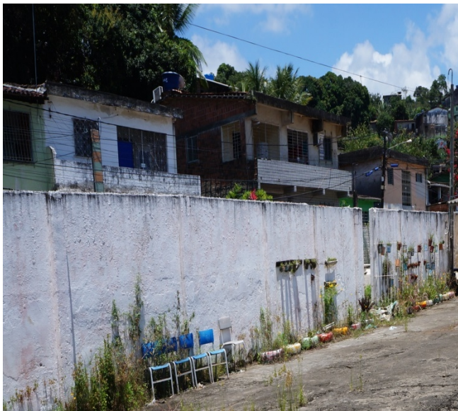
FOTO 47 – Pintura do muro lado interno e externo em tinta PVA látex.
