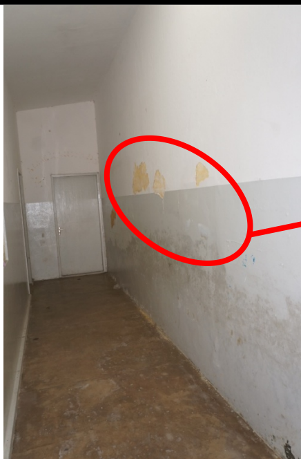
FOTO 27 – Retirada do reboco com aplicação de novo reboco - após colocar cerâmica a meia parede inferior (1,7m) e pintura em tinta látex na meia parede superior.
