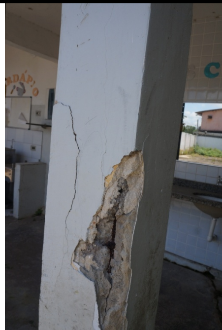
FOTO 12 - Recuperação estrutural do pilar com aplicação de graute, inclusive da base, com retirada do material desagregado, lixamento da ferragem, proteção da ferragem com primer e recomposição da ferragem quando necessário.
