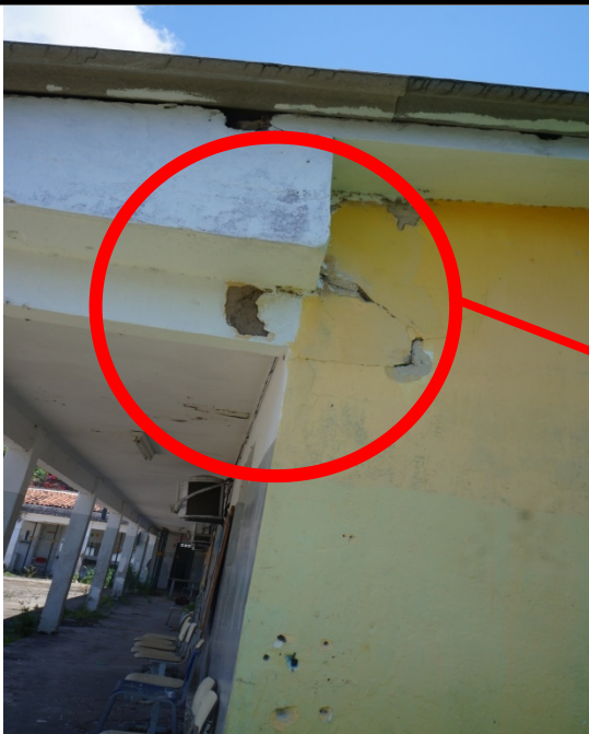
FOTO 03 – Recuperação estrutural com amarração da viga.
