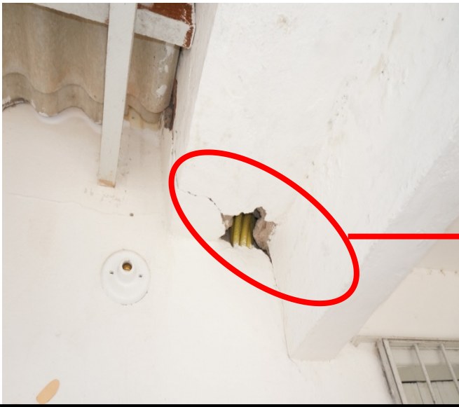
FOTO 21 – Instalação de caixa de passagem 4x4 e recuperação das rachaduras.
