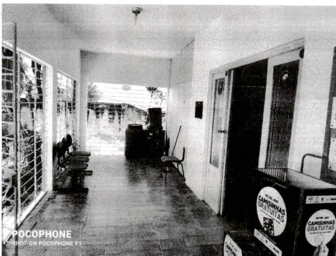
TERRAÇO FRENTE, EM BOM ESTADO DE CONSERVAÇÃO.
