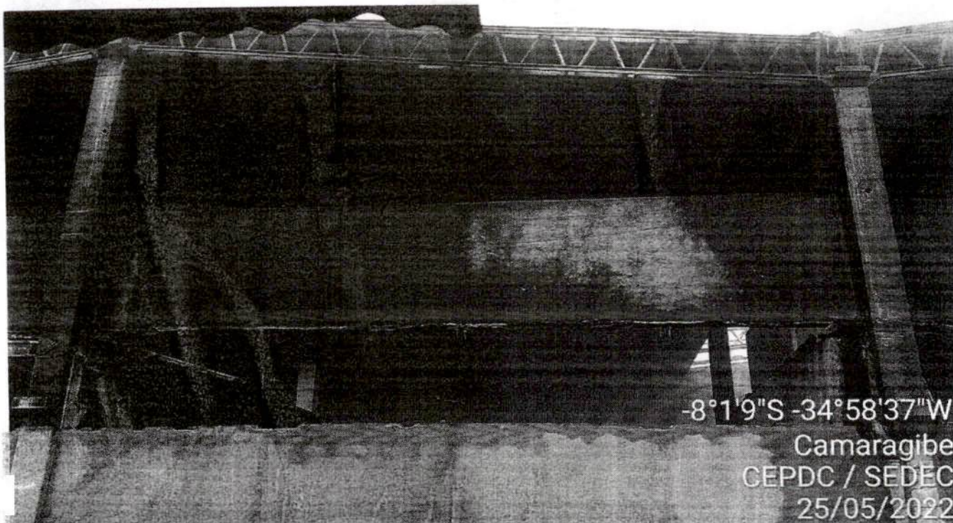
Fig.8 - Alvenaria de fachada, sem o apoio da laje, apresentando fissuras e evidências de colapso próximo.
