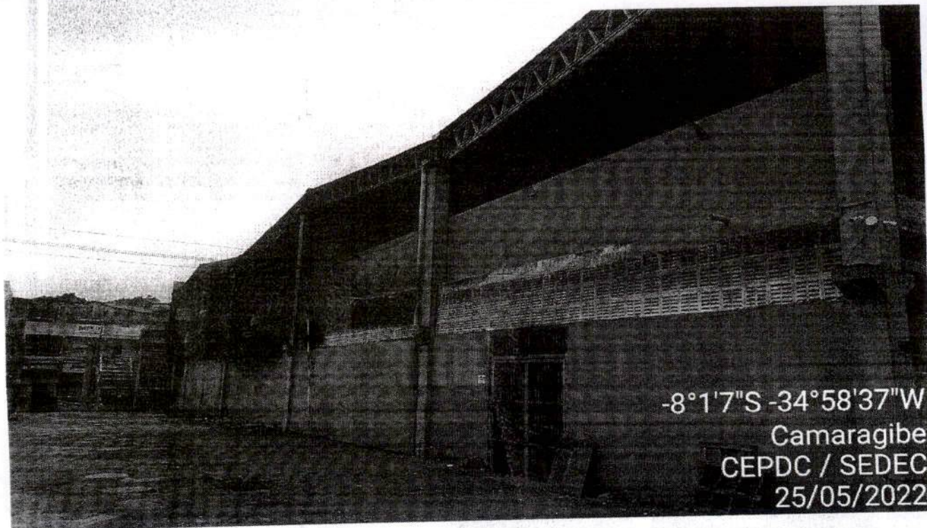
Fig.4 - Vista da fachada lateral direita da edificação.
