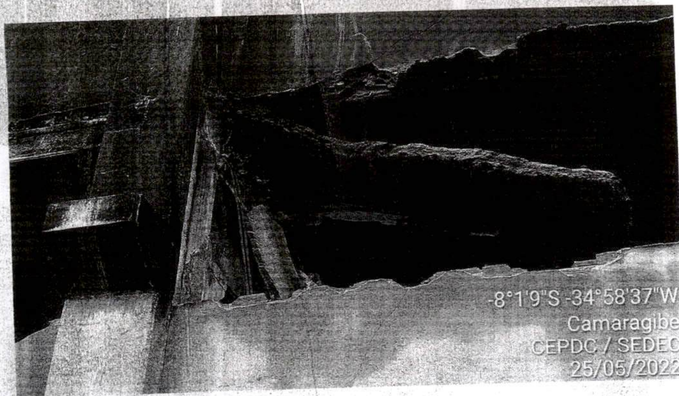
Fig.8 - Laje colapsada e armadura exposta.
