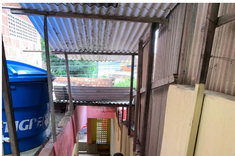
Figura 7 – Laterais da escada. Fonte: Prefeitura Municipal de Camaragibe, 2023.
