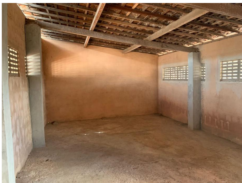
Figuras 2 e 3 – Telhado aparente no pavimento superior. Fonte: Prefeitura Municipal de Camaragibe, 2023.
